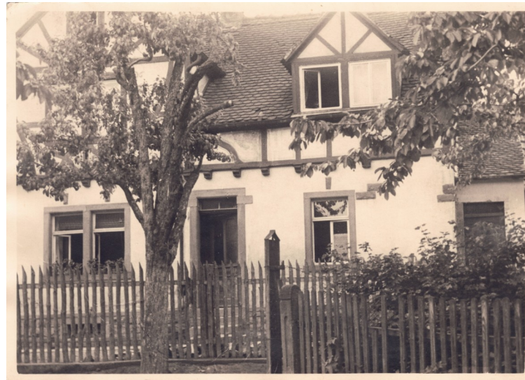
Wohnhaus mit angrenzender Schreinerei in Hausen
